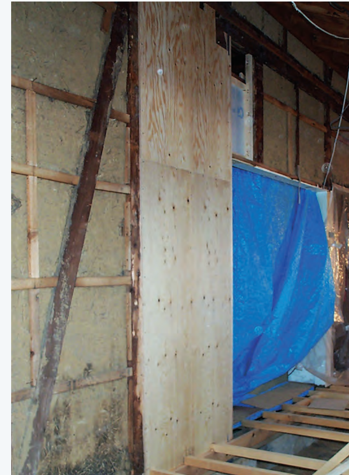
構造用合板で補強壁倍率4.0に
