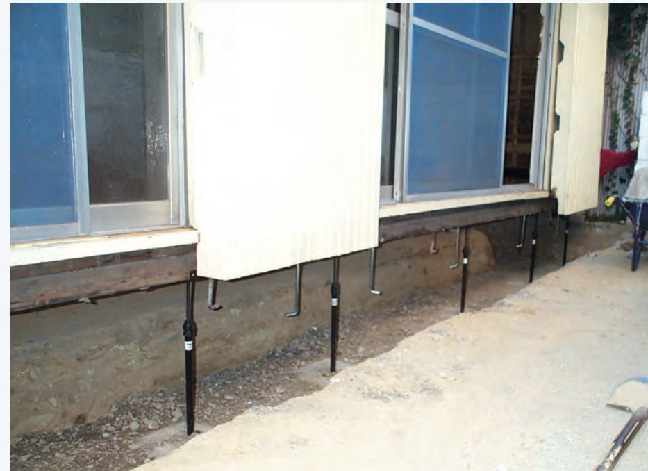
ブロック基礎撤去、鋼製束で仮支持
