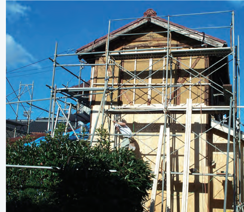
1階部分構造用合板張り
