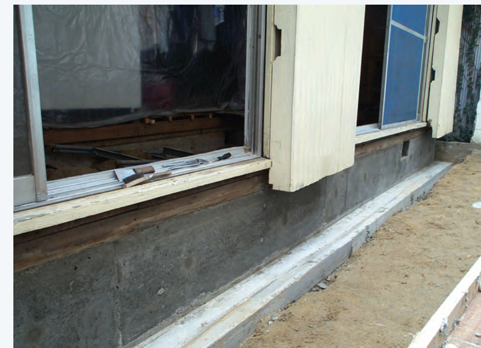
コンクリート基礎に打ち替え
