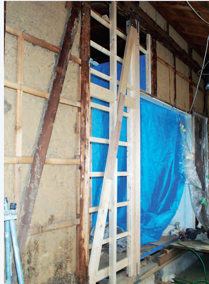
壁下地を作成筋交いで補強
